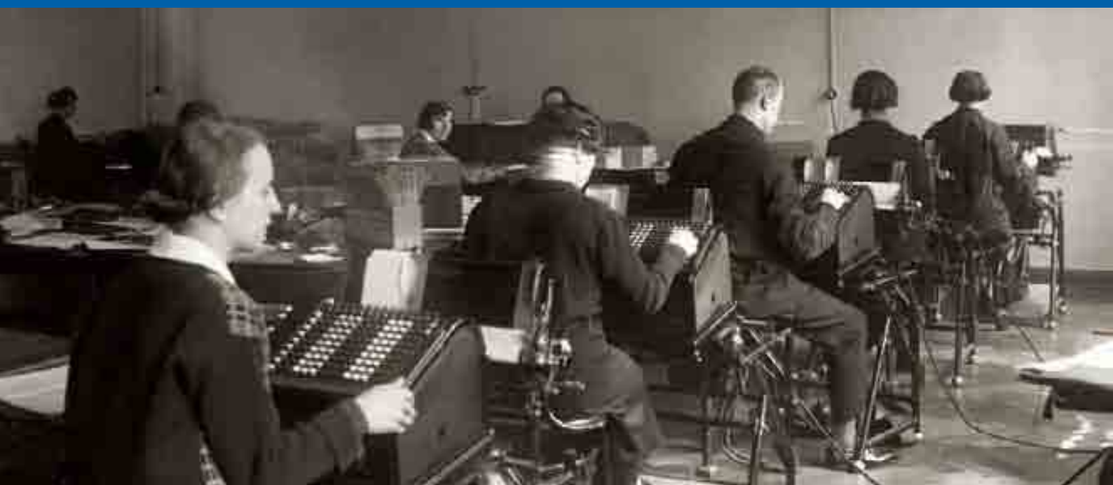
↓ Hala maszyn w centrali Pocztovej Kasy Oszczędności w latach 30. Typewriter room in the PKO headquarters in the 1930s. ↓
