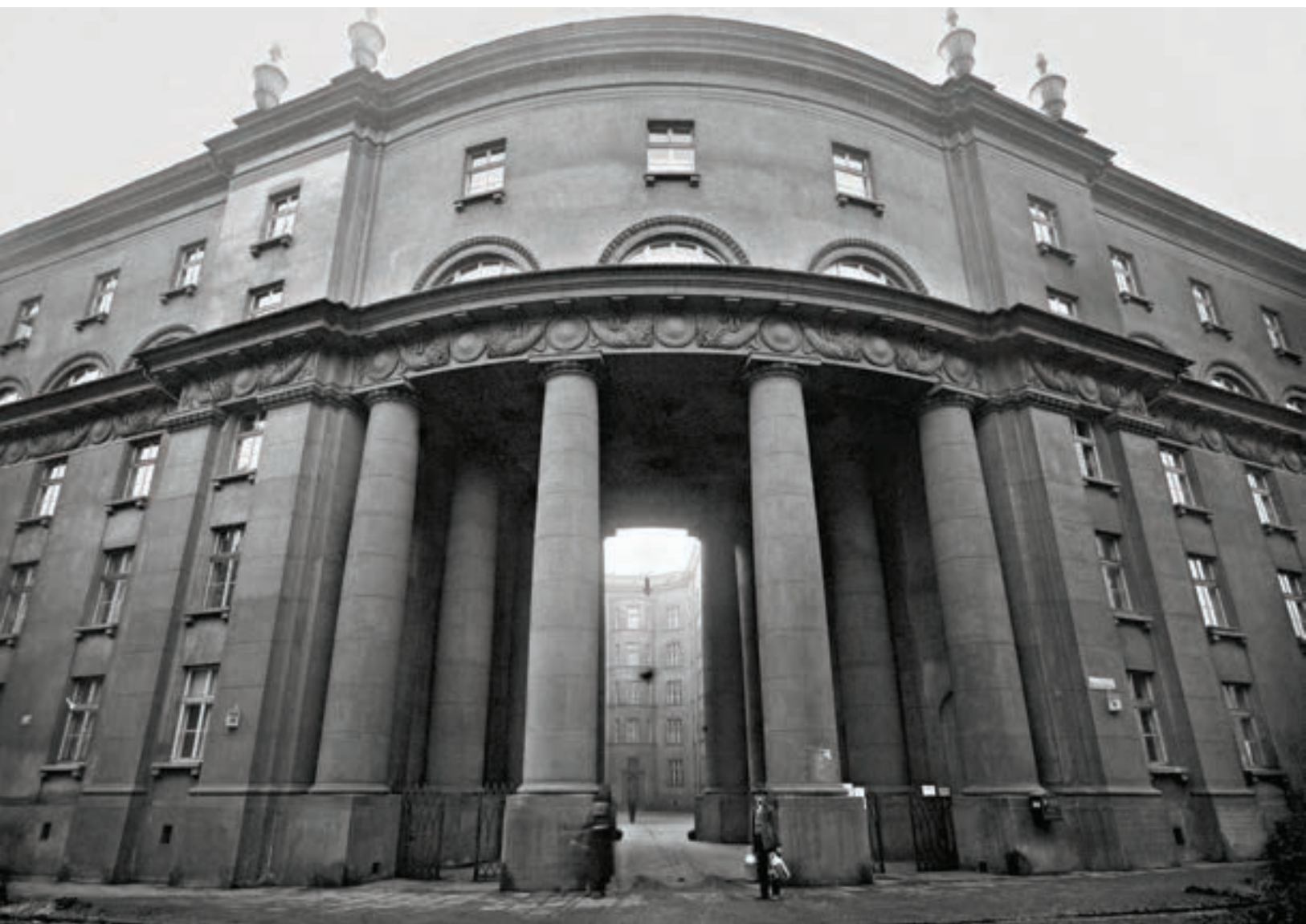
↑ Budynek z mieszkaniami dla pracowników PKO przy ulicy Żybkiewicza
