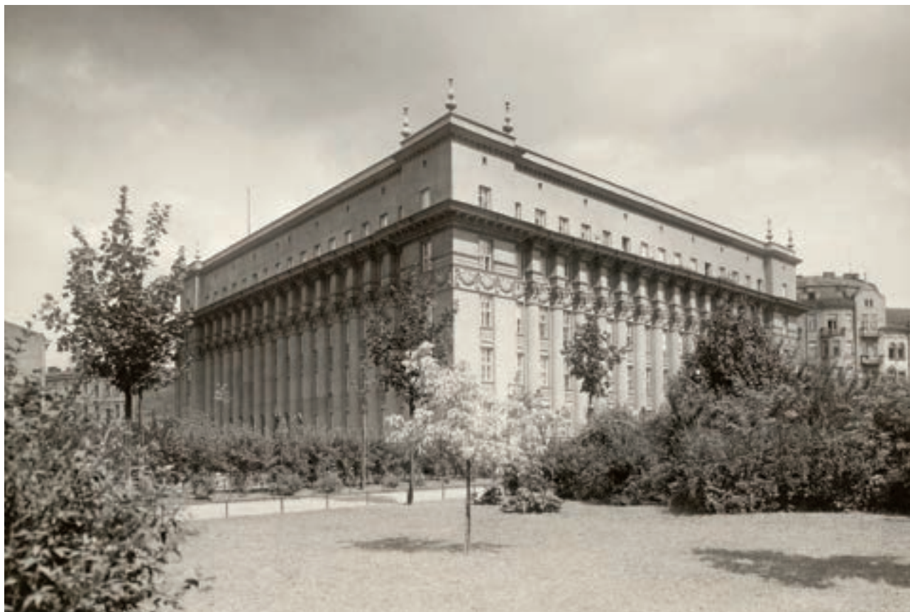
↑ Gmach PKO od strony Plant Dietlowskich
