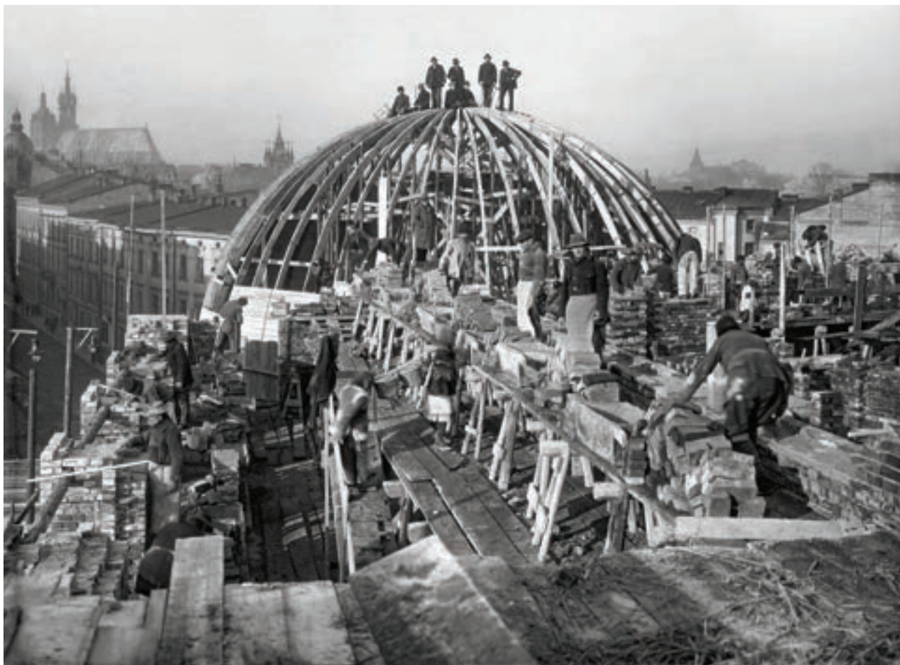
↑ 1923. Budowa kopuły gmachu PKO
